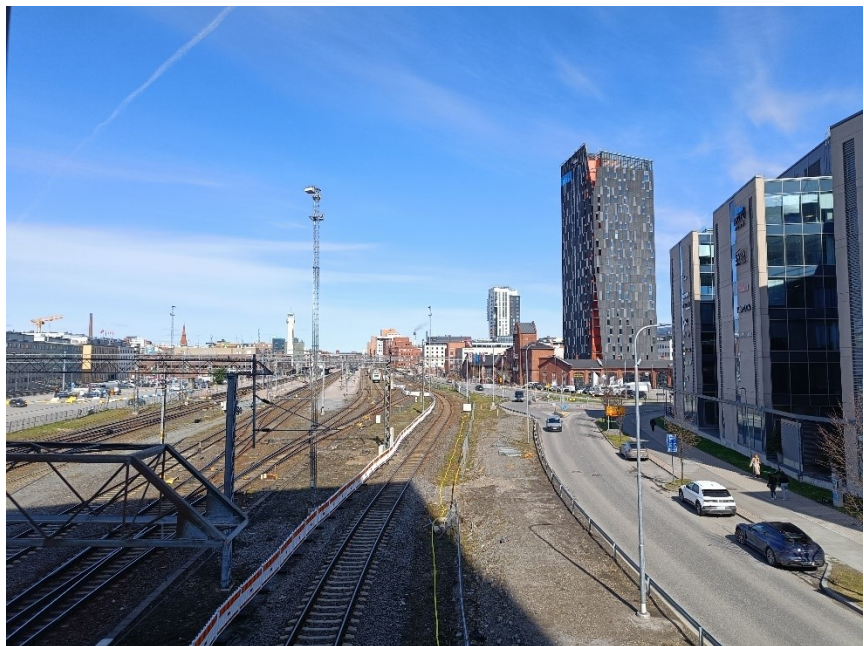
Kuva 7. Näkymä pohjoiseen Sorin sillalta. (Tampereen kaupunki 2025)
